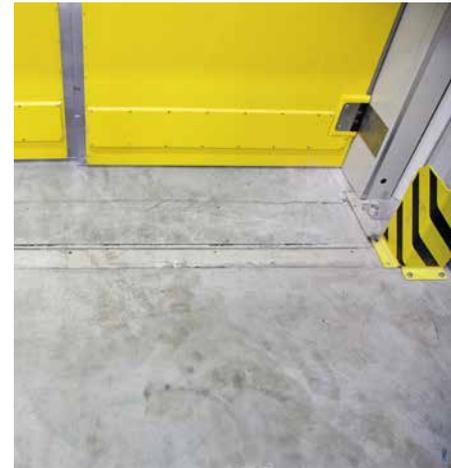
Bodenschleppzunge mit Fahrbereichsheizung
