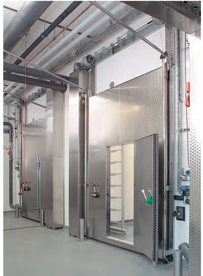
Hubtore im V2A passgenau geplant und eingebaut.
