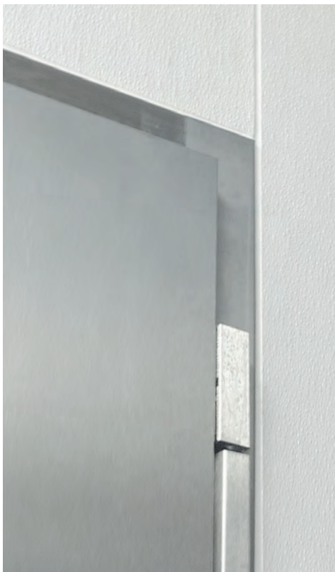
Flächenbündiger Türrahmeneinbau
